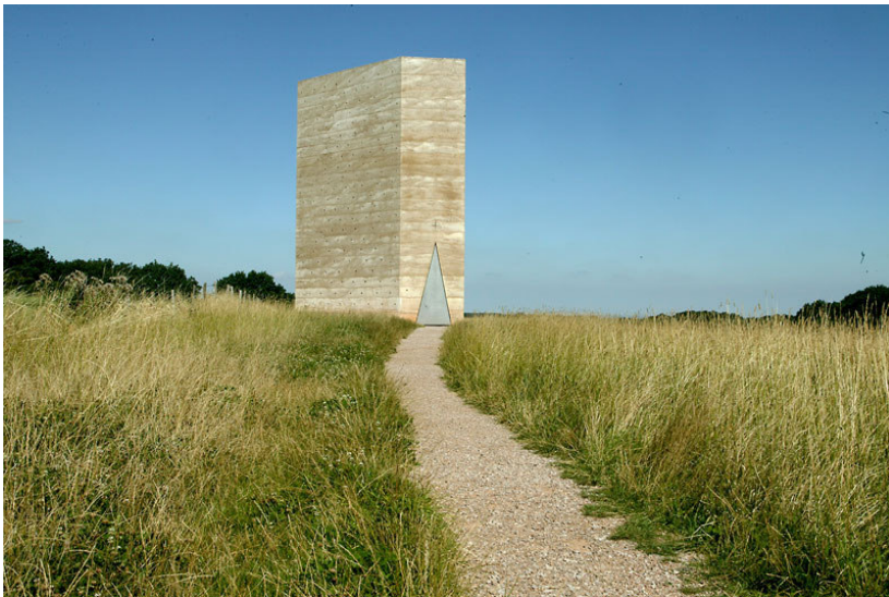
Die Bruder-Klaus-Feldkapelle ist eine privat gestiftete und 2005 bis 2007 erbaute römisch-katholische Kapelle oberhalb der Ortschaft Mechernich-Wachendorf, am Nordrand der Eifel.
